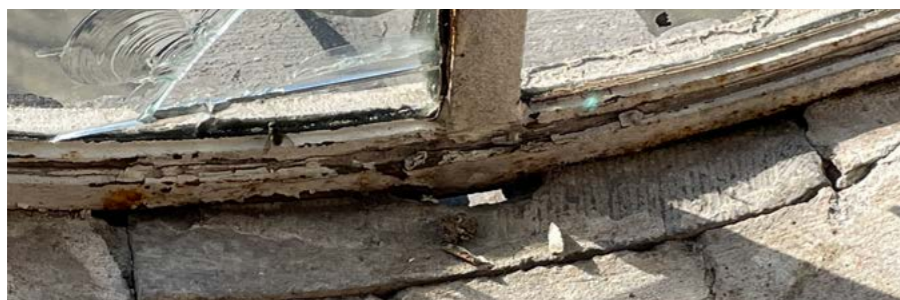
Een mooi detail is de hardstenen condensspuwer aan de onderzijde van ronde stalen ramen.
